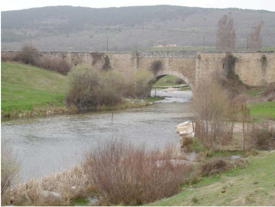
Foto: Puente de Valsain desde el río Eresma.
